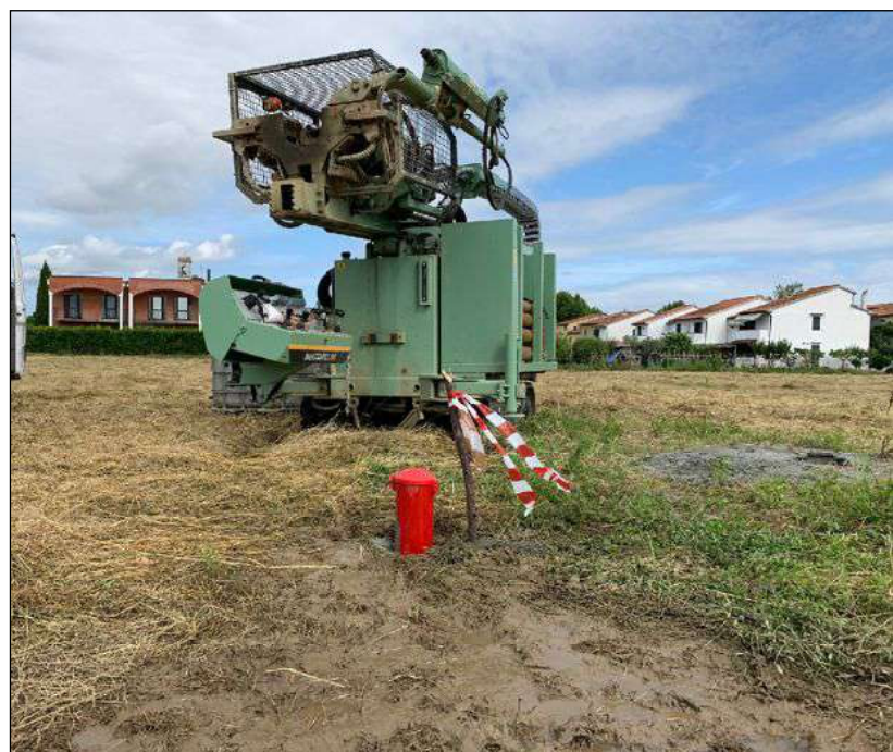
Foto n.4 : Protezione testa del tubo piezometrico in S2.
