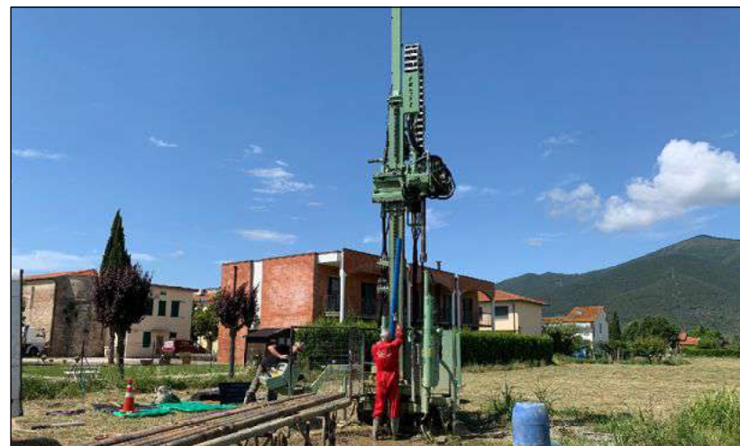
Foto n.9 : Postazione S1 e calo tubazione nel foro di S1 per la prova sismica Down Hole.
